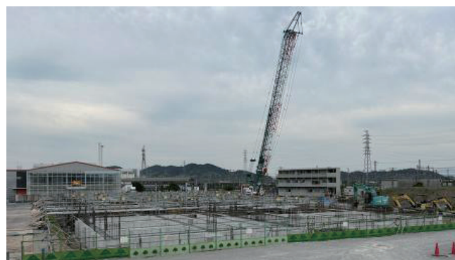
現在の建設地の様子(令和7年6月6日)
