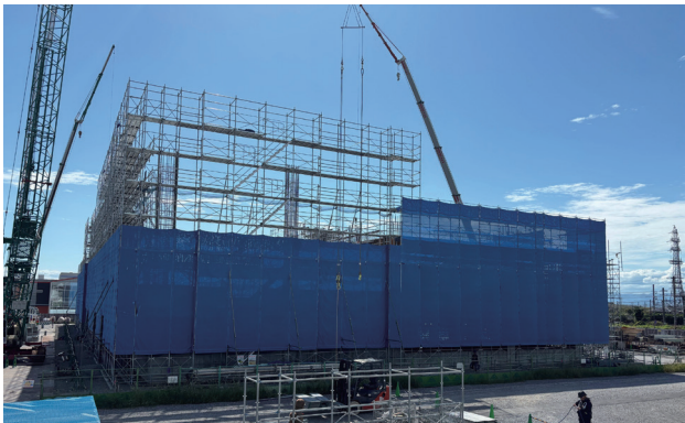
現在の建設地の様子(令和7年9月19日)
